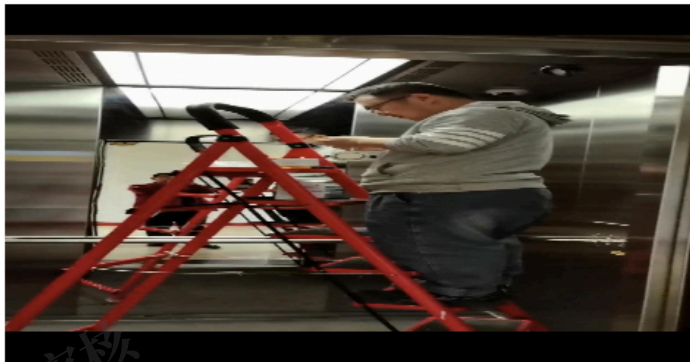
检查维修电梯
